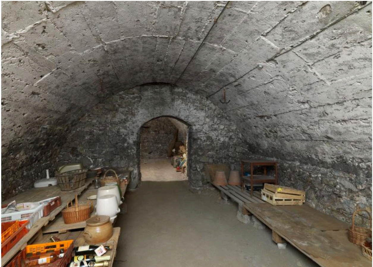
Vue d'ensemble des caves voutées de la demeure situées en sous-sol.
