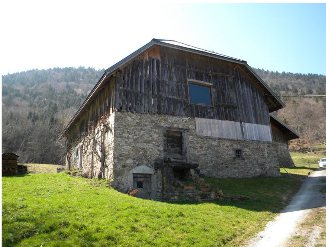
Vue du mur pignon nord-est.
