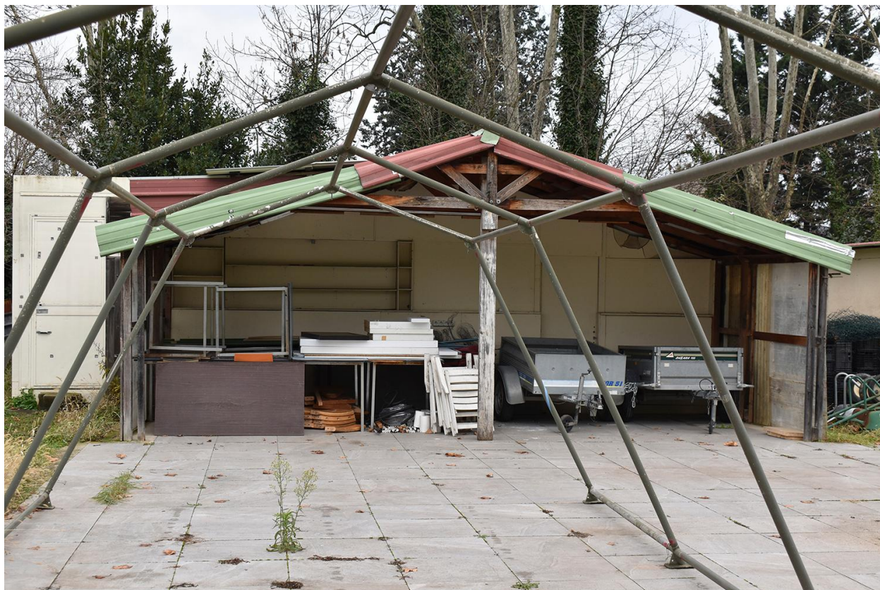
Abri de stockage des jardins ouvriers de la Rize
