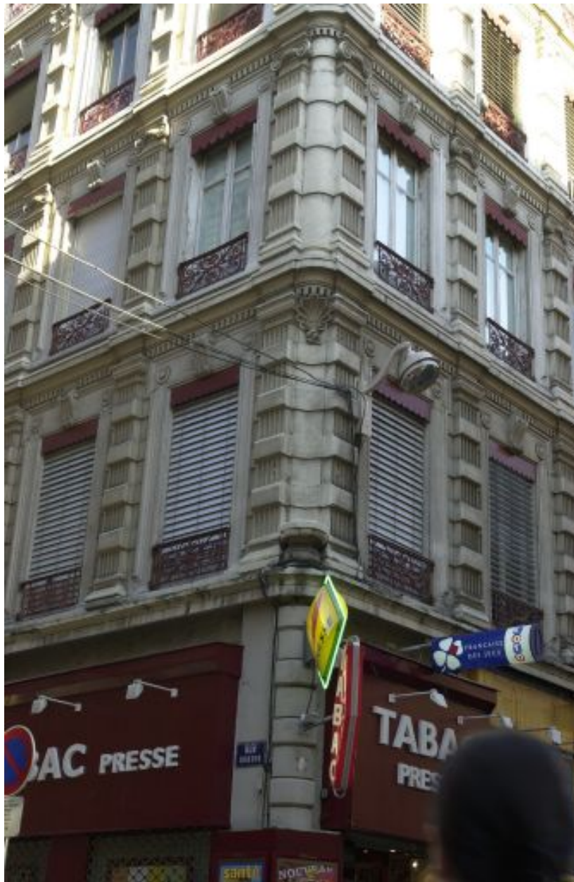
Angle des deux façades, détail des trois premiers niveaux
