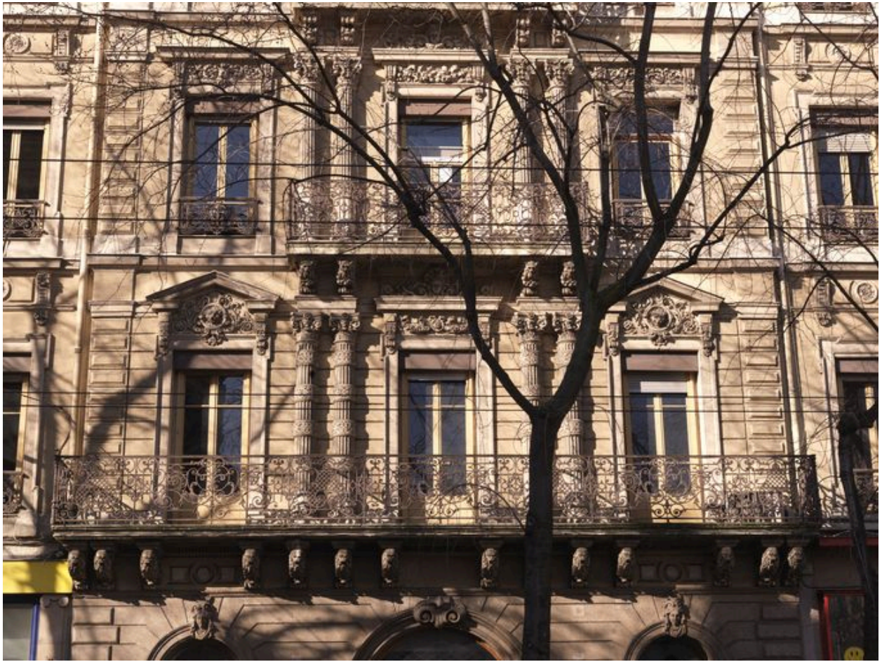
Détail de la travée centrale.
