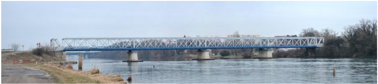
Vue panoramique, face aval (depuis la rive droite)
