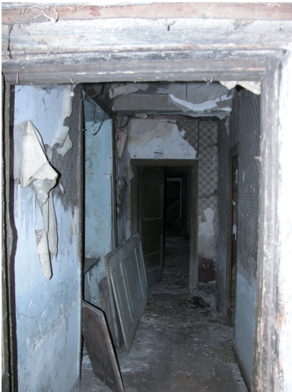
Vue intérieure du rez-de-chaussée : couloir.
