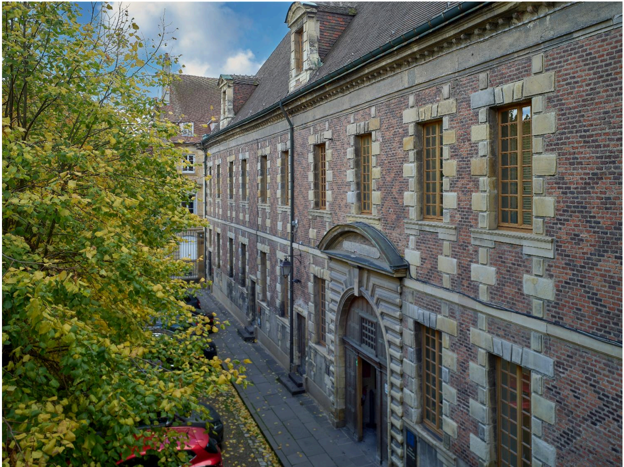
Aile nord, élévation sur cour
