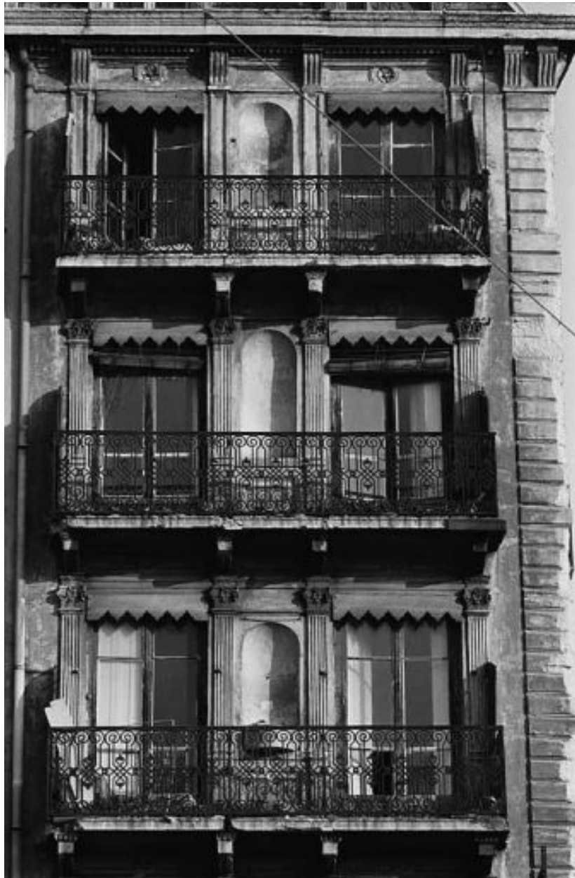
Façade sur le quai, niveaux 4 à 6
