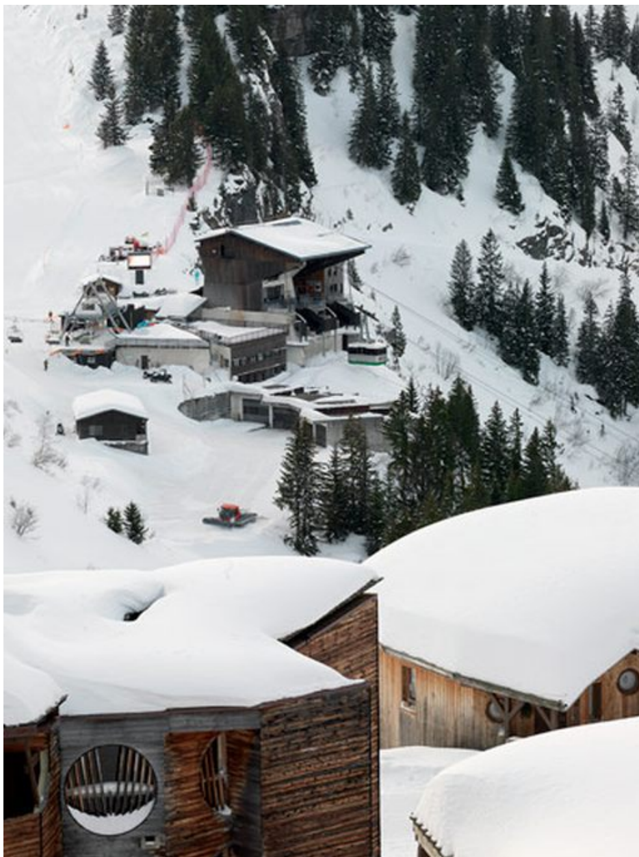
Vue générale depuis le nord avec la cabine en mouvement
