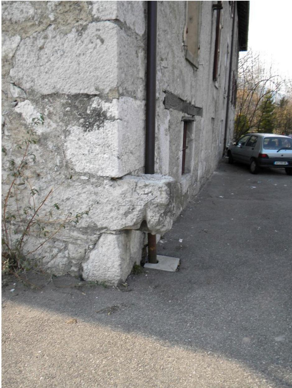
Détail d'une pierre en saillie au bas d'un chaînage à l'arrière du bâtiment.
