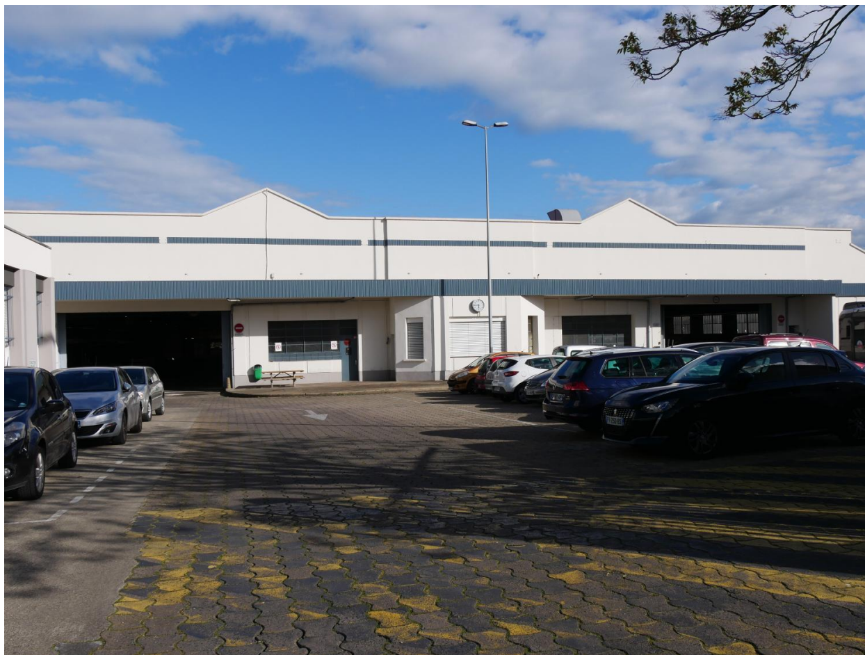
Vue d'ensemble dépôt TCL Moulin à vent
