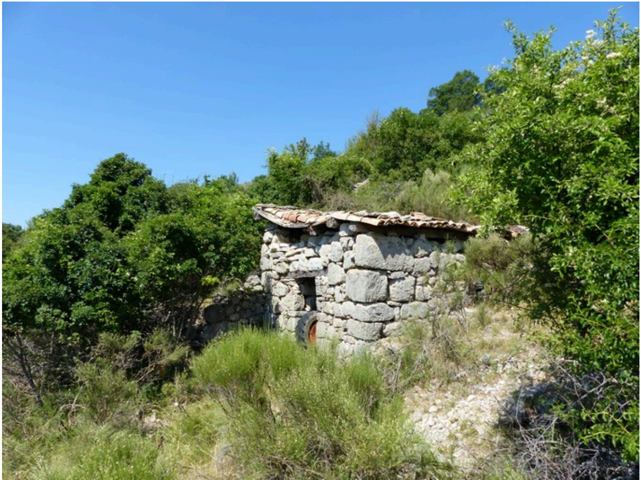
Vue de situation prise du sud-est.
