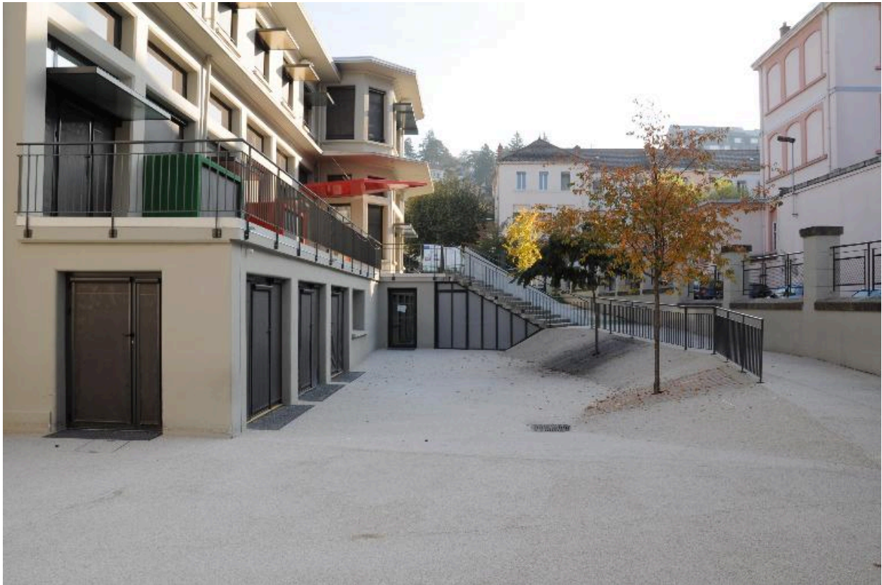
Vue de la cour depuis l'ouest
