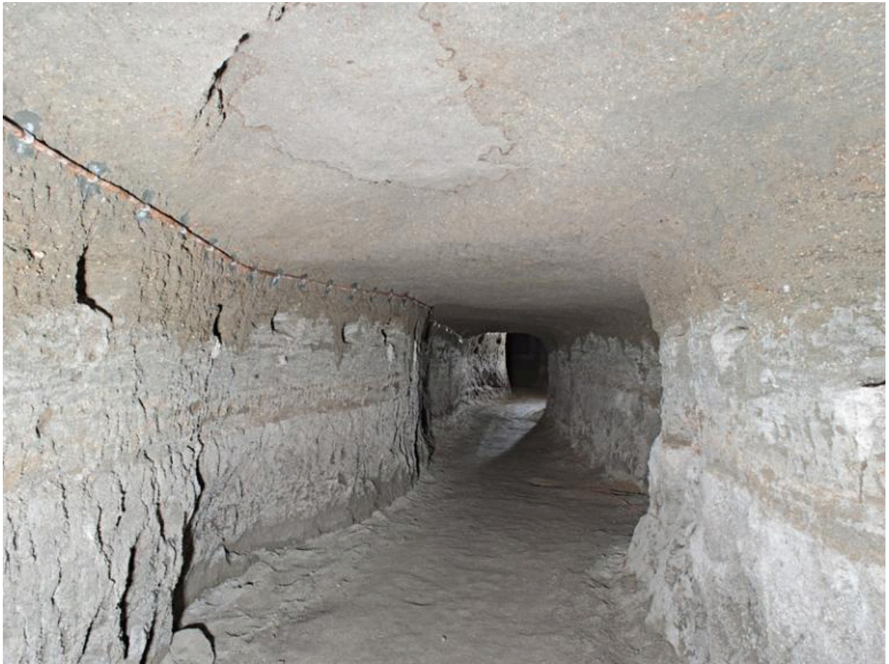
Hôtel-Dieu de Clermont-Ferrand. L'hôtel-Dieu, les galeries souterraines, galerie de liaison orientale.
