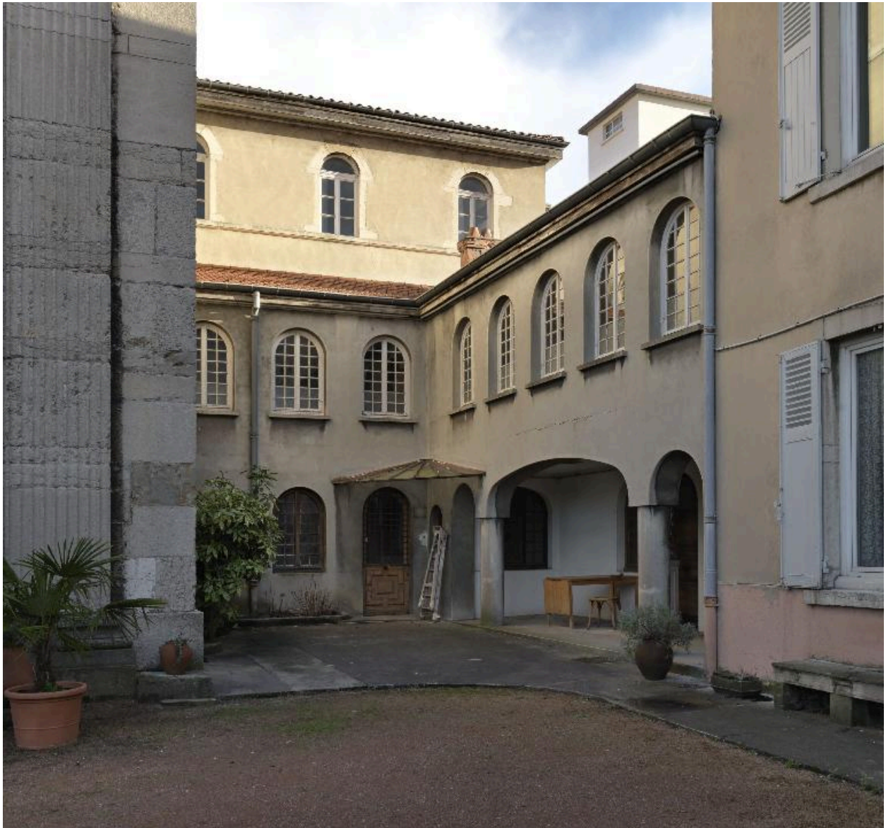
Dépendances : vue partielle depuis la cour précédant la chapelle Notre-Dame des Martyrs
