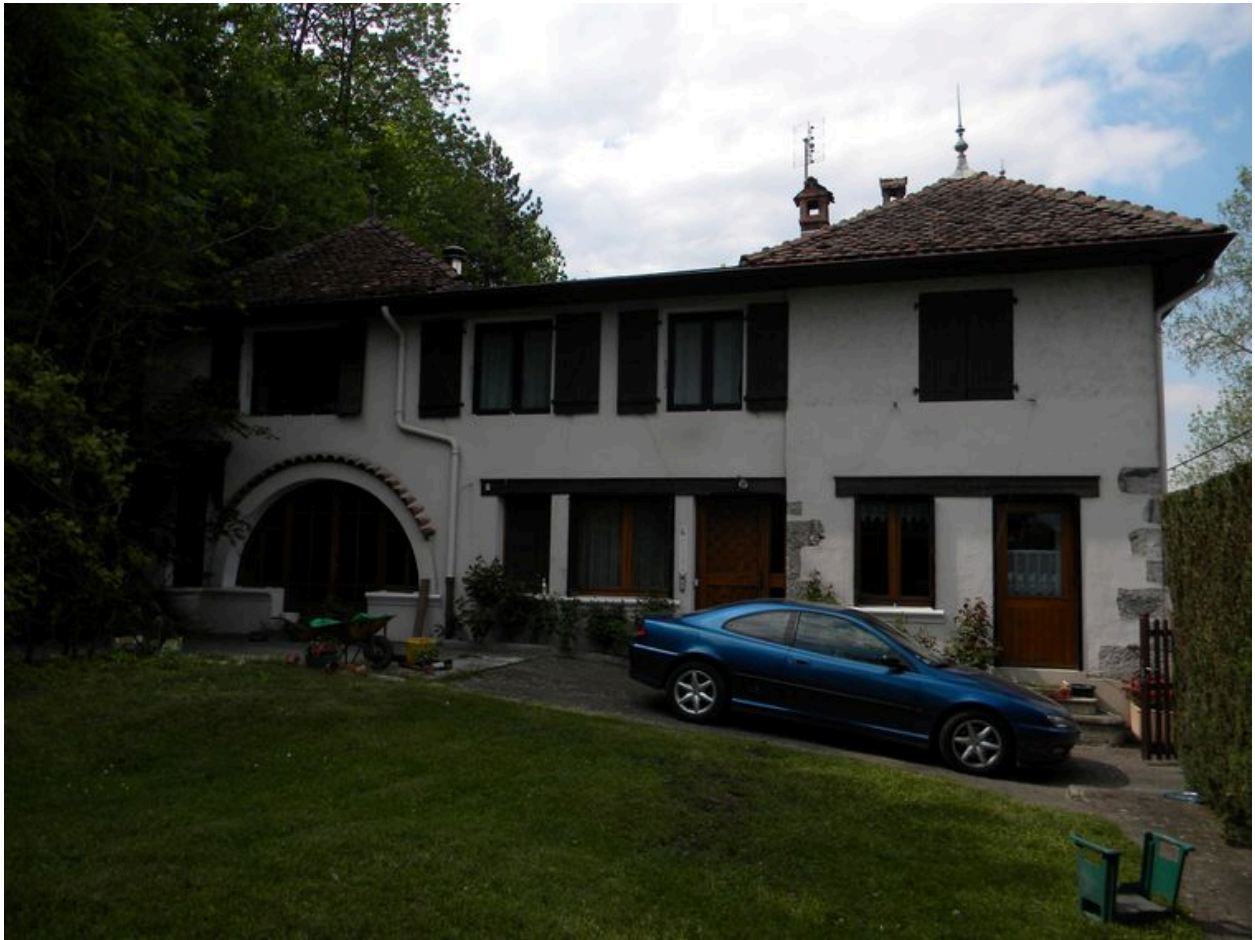
Vue de la façade principale orientée au sud.
