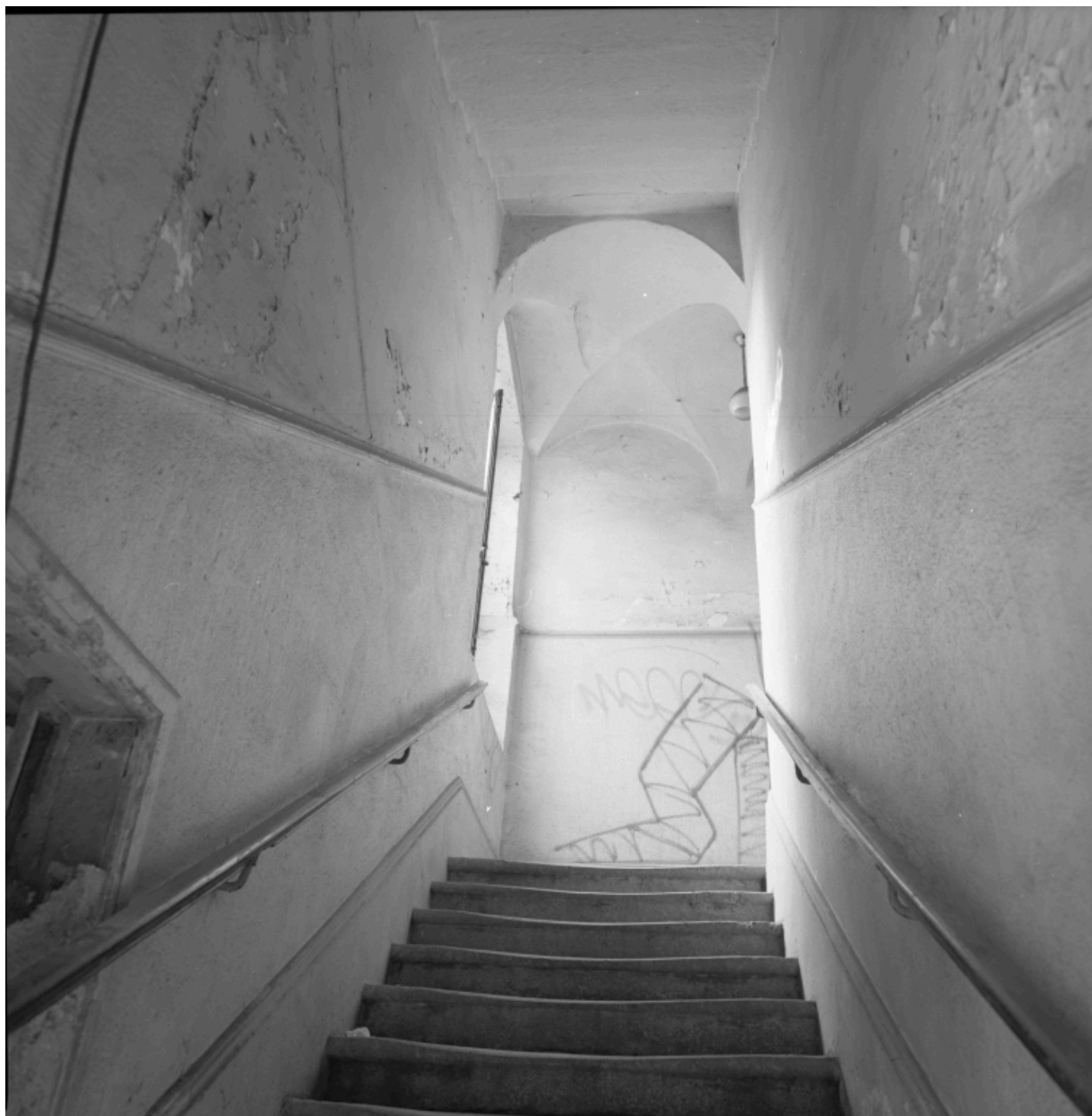
Vue de la montée d'escalier
