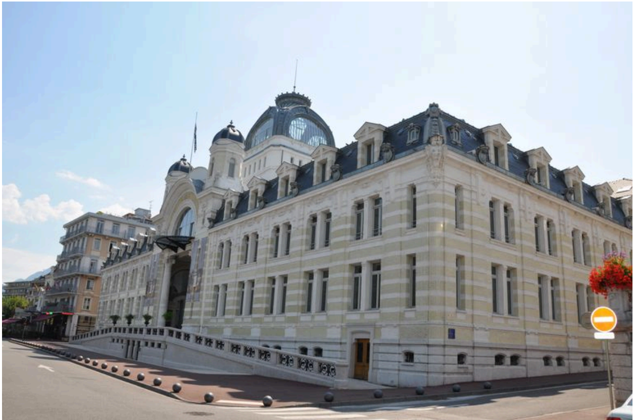
Vue d'ensemble du bâtiment prise depuis le quai Charles Albert Besson
