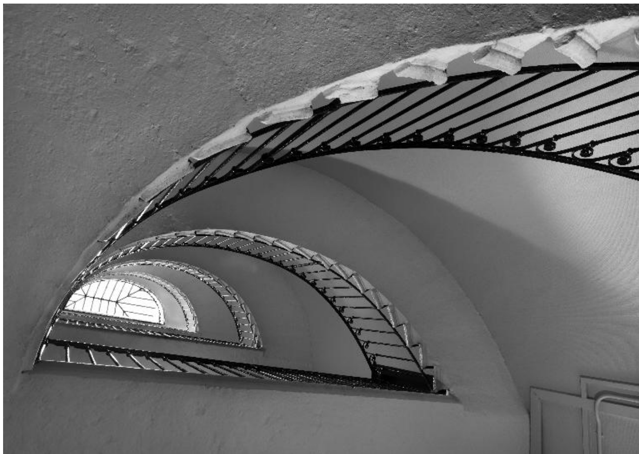
Vue de l'escalier depuis le rez-de-chaussée
