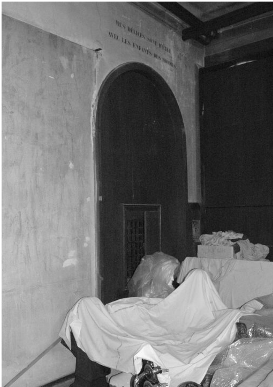
Sacristie intérieure, vue du mur ouest, détail
