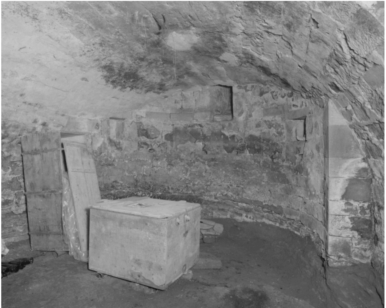
Vue intérieure de l'abside de l'ancienne chapelle.
