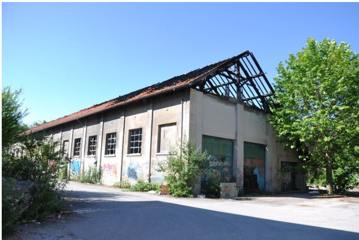
Elévation nord-ouest du bâtiment, magasin n°6.
