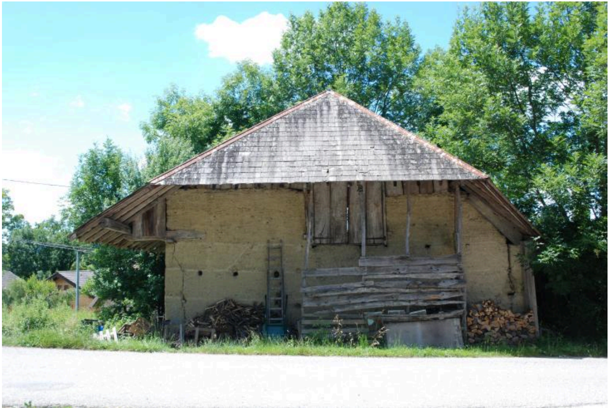
Vue du mur pignon.
