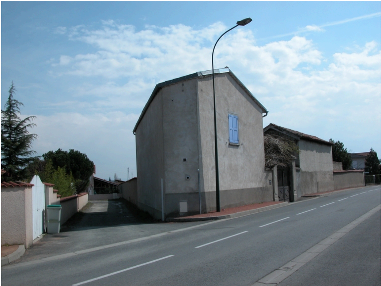
Ancien cuvage, puis maison de forgeron, à Chantemerle (1997 AP 58).
