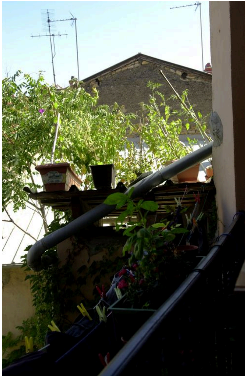
Vue générale depuis une coursière de l'immeuble sur rue
