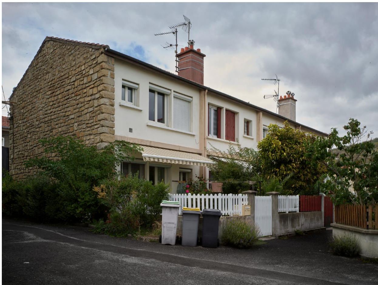
Maisons de la cité de Chanteranne, rue de Bien-Assis : élévation postérieure (est) des maisons en bande sur rue.
