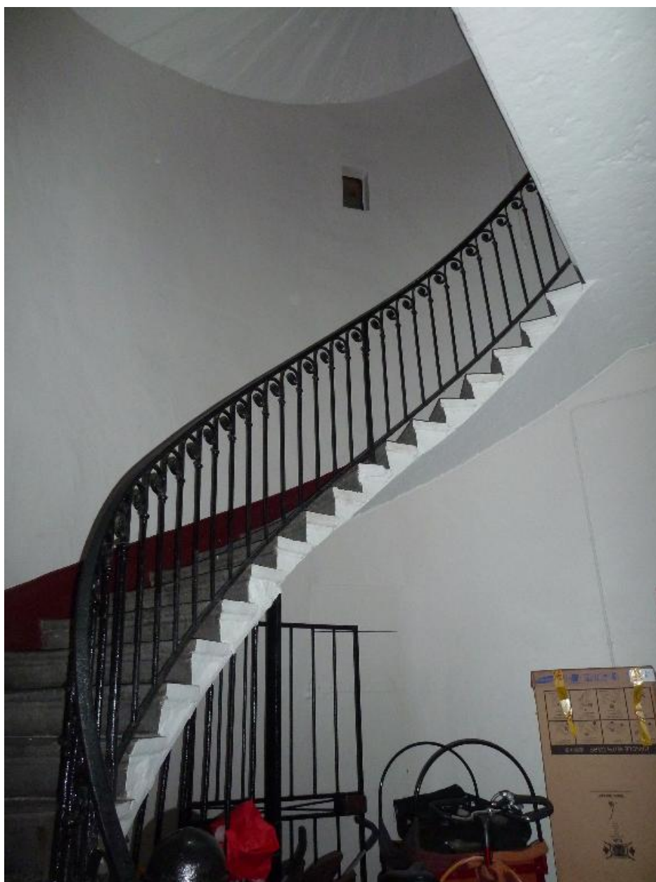
Vue de la première volée de l'escalier
