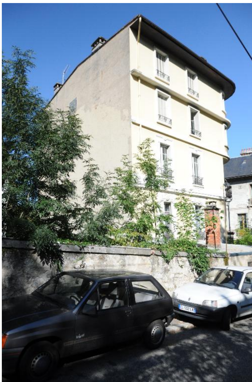
Vue depuis l'arrière: façades latérale droite (façade sud) et postérieure (façade est)
