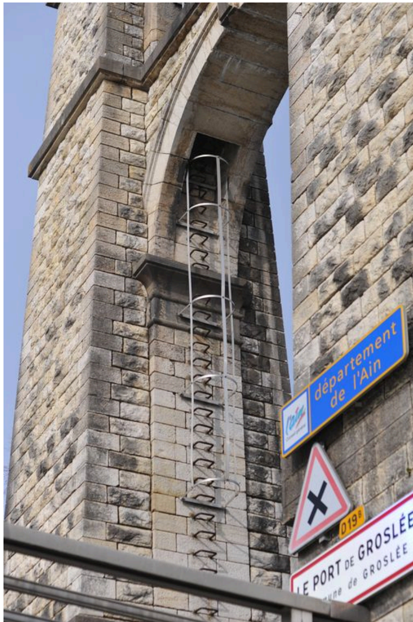
Pylône droit, face amont, vue partielle : accès au sommet, partie inférieure (depuis la rive droite)
