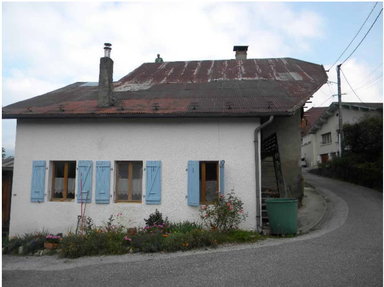
Vue d'un bâtiment très modifié (2008 E8 1115).
