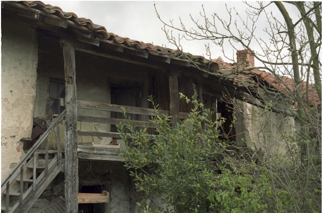
Arthun, la Terrière (1987 A1 835, 836). Détail de la galerie (logis divisé).
