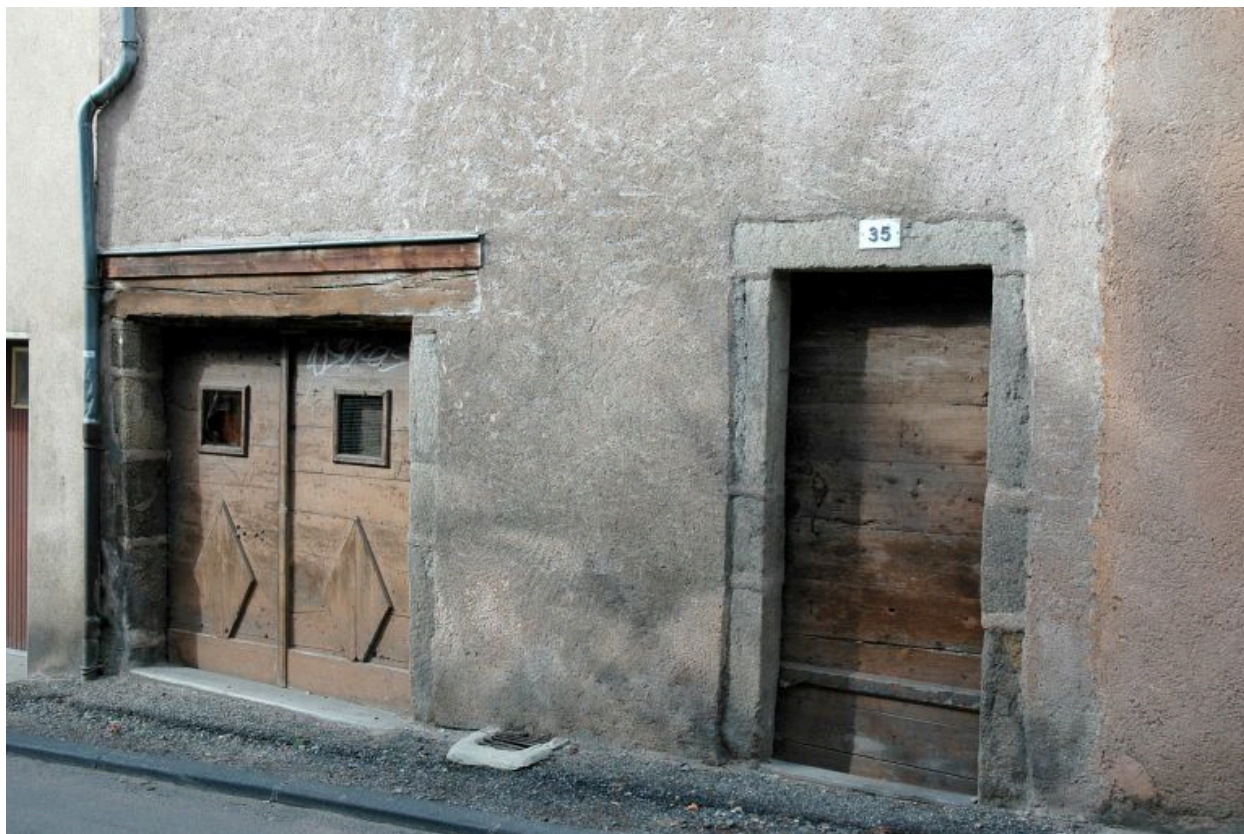
Rez-de-chaussée d'une maison de type 1 : atelier et porte piétonne, rue Bourgneuf.
