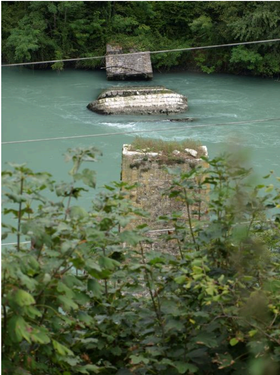
Vestiges des piles, vue générale (depuis la rive droite)
