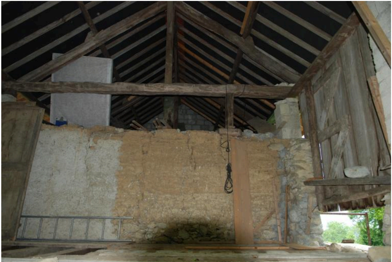
Vue du mur nord (pisé).
