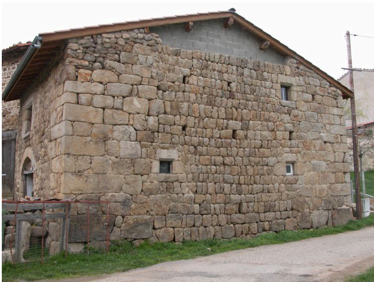
Etable à l'est, vue d'ensemble du mur pignon.
