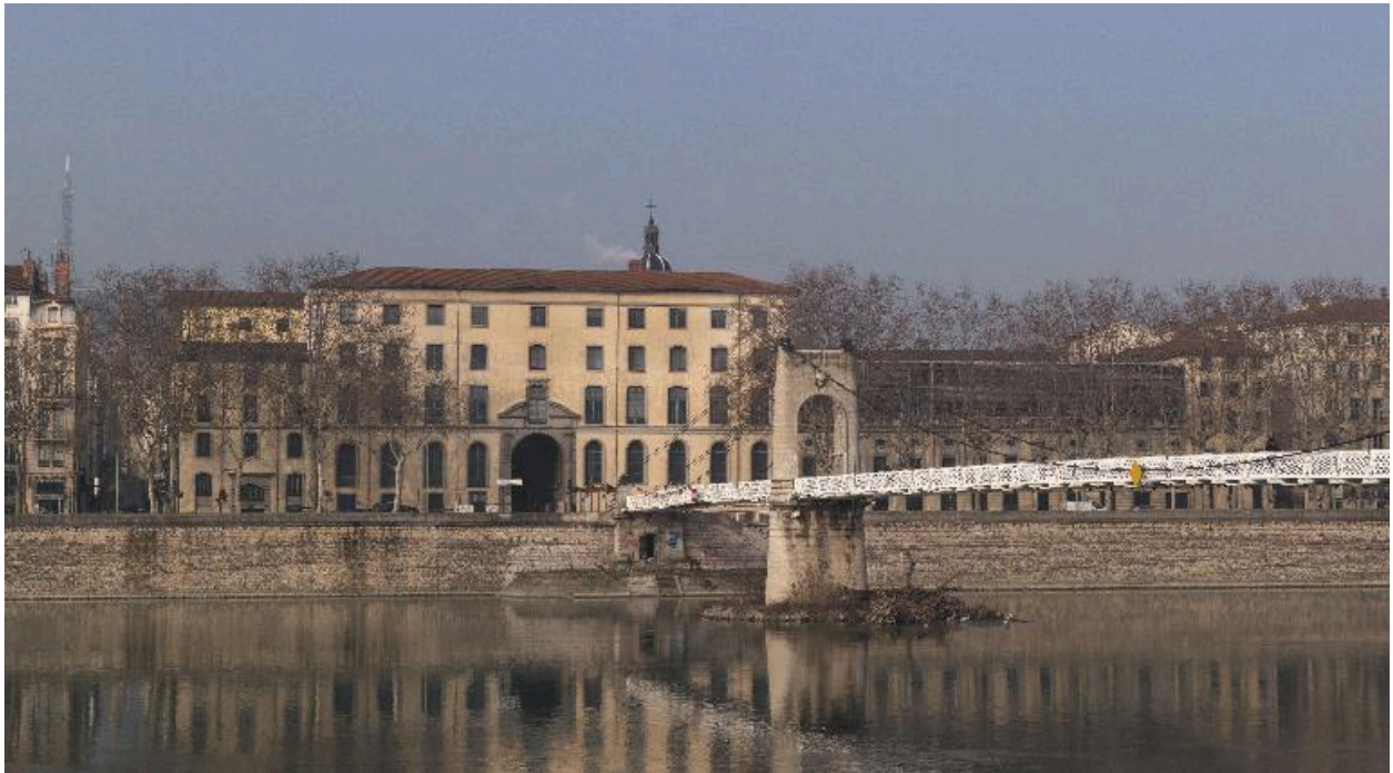
Vue générale de l'élévation postérieure depuis quai Général Sarrail
