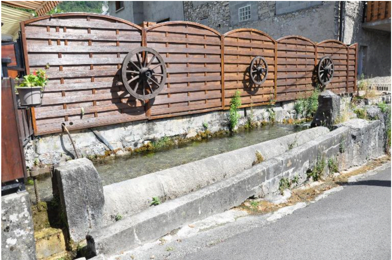
Vue du canal-déversoir, 2014.
