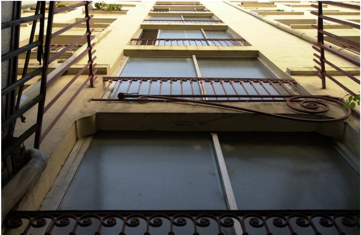
Elévation sur cour : la travée d'escalier
