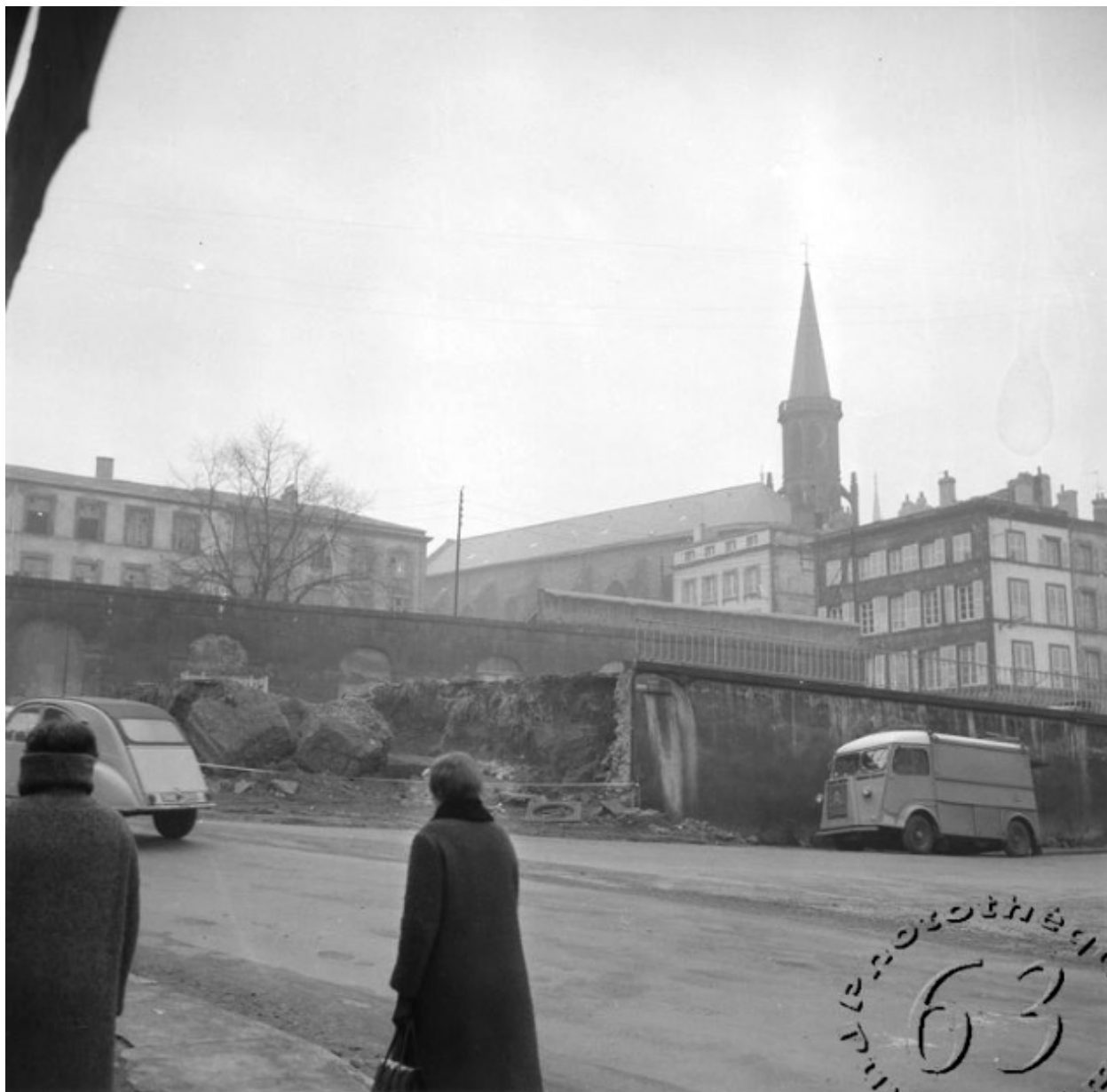
Place Michel de l'Hospital : vue depuis le sud-est des arcades du mur de clôture et du mur de soutènement du lycée en cours de démolition, fin 1966 (AD Puy-de-Dôme, 616 Fi 4548)
