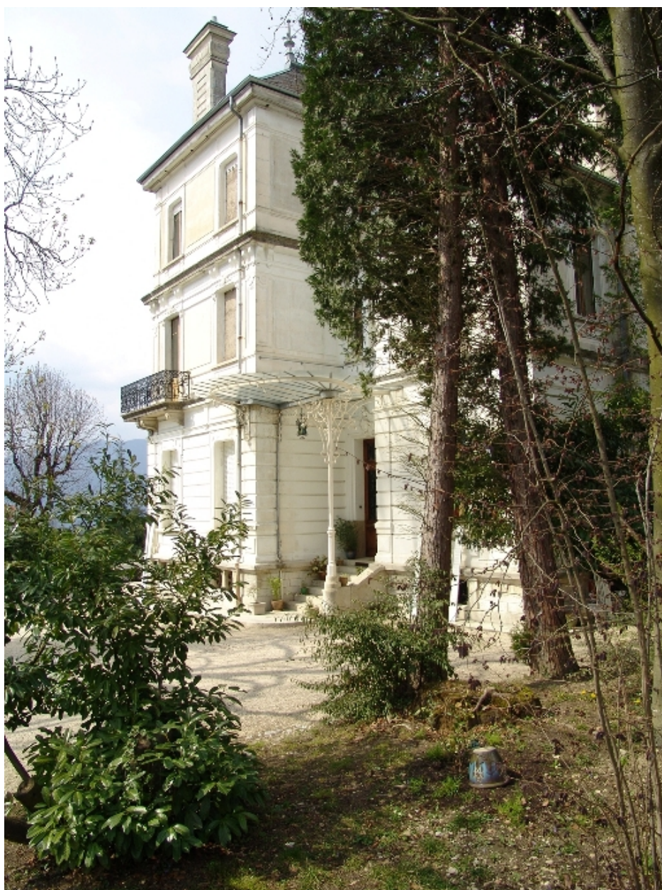
Façades latérale droite vue de trois-quart
