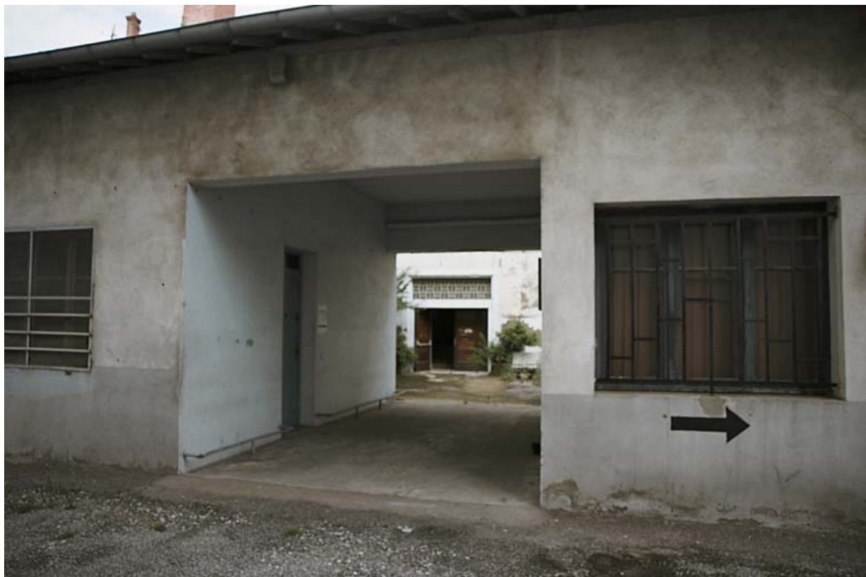
Passage : accès au bâtiment principal
