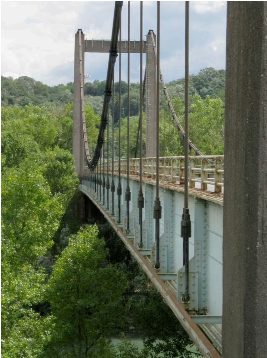
Parapet et câbles, vue partielle, face aval (depuis la rive gauche)
