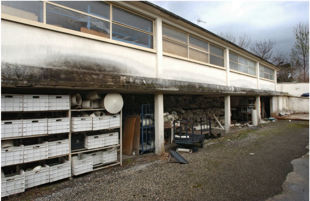
Vue extérieure des bâtiments
