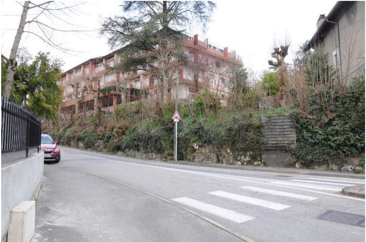
Vue générale depuis le sud
