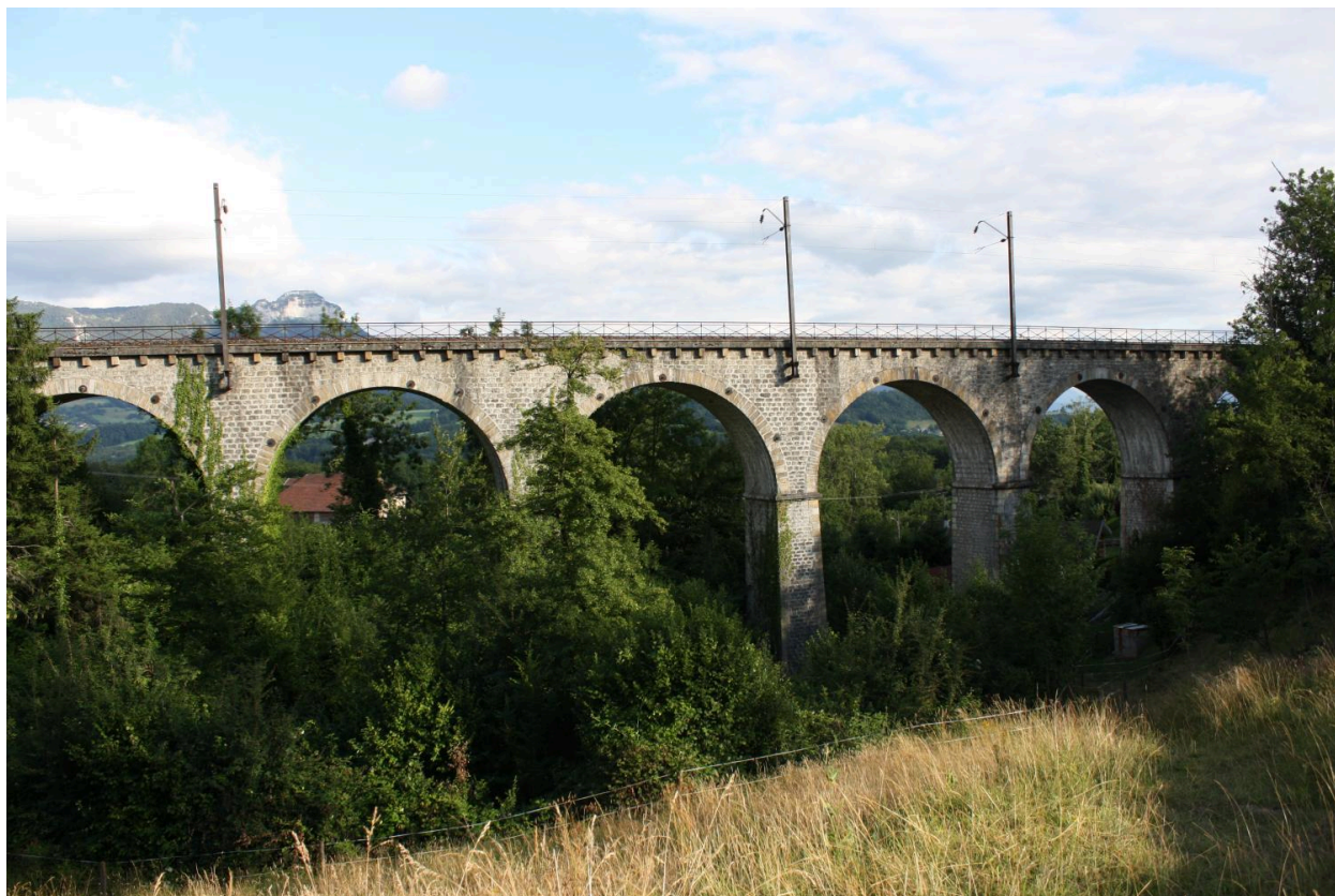
Viaduc du Gantet, face amont
