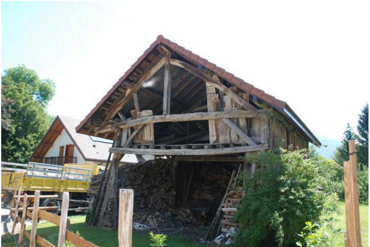
Vue de la remise 2016 B5 490, non repérée.
