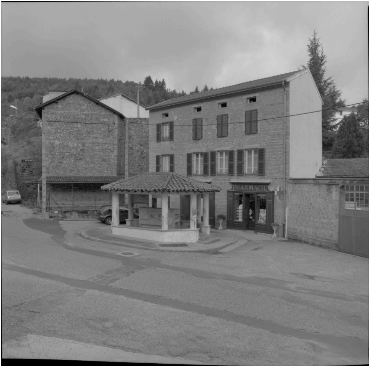
Vue générale de la fontaine Font Fort au-devant de la pharmacie et de l'Astrée.
