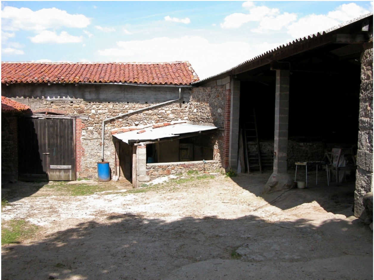
Vue d'ensemble de la cour depuis le portail.
