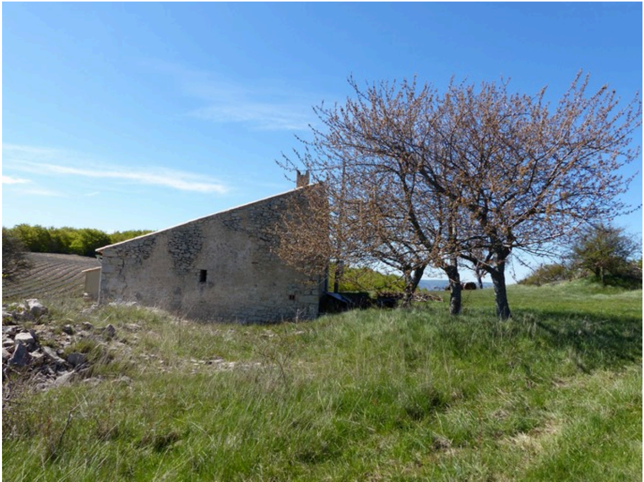
Vue d'ensemble prise du nord.
